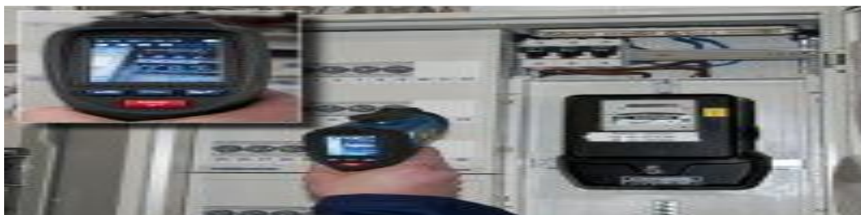
Slika 4. Primjena infracrvenog termometra
