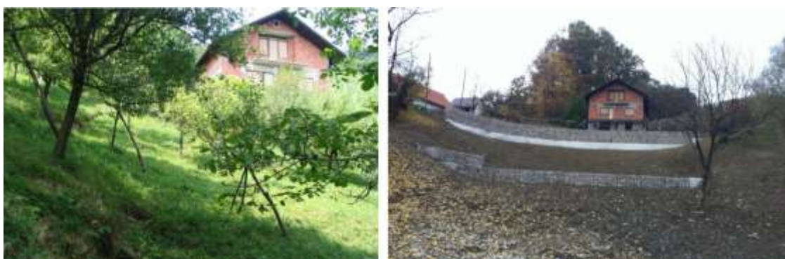
Slika 11: a) prije sanacije; b) sanirano/poslije sanacije
